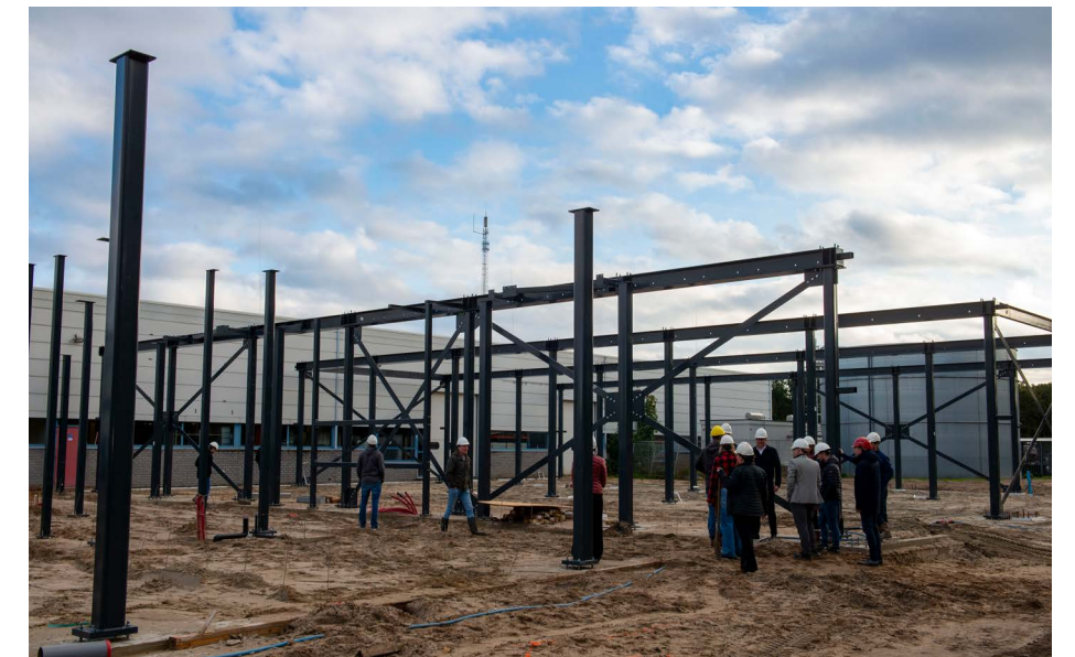
Bouwoffer voor het nieuwe depot aan de Nieuwe Dukenburgseweg
